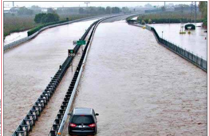
✓ L'autostrada trasformata in un lago nel veronese ✓ A autoestrada transformada num lago, na região de Verona.
